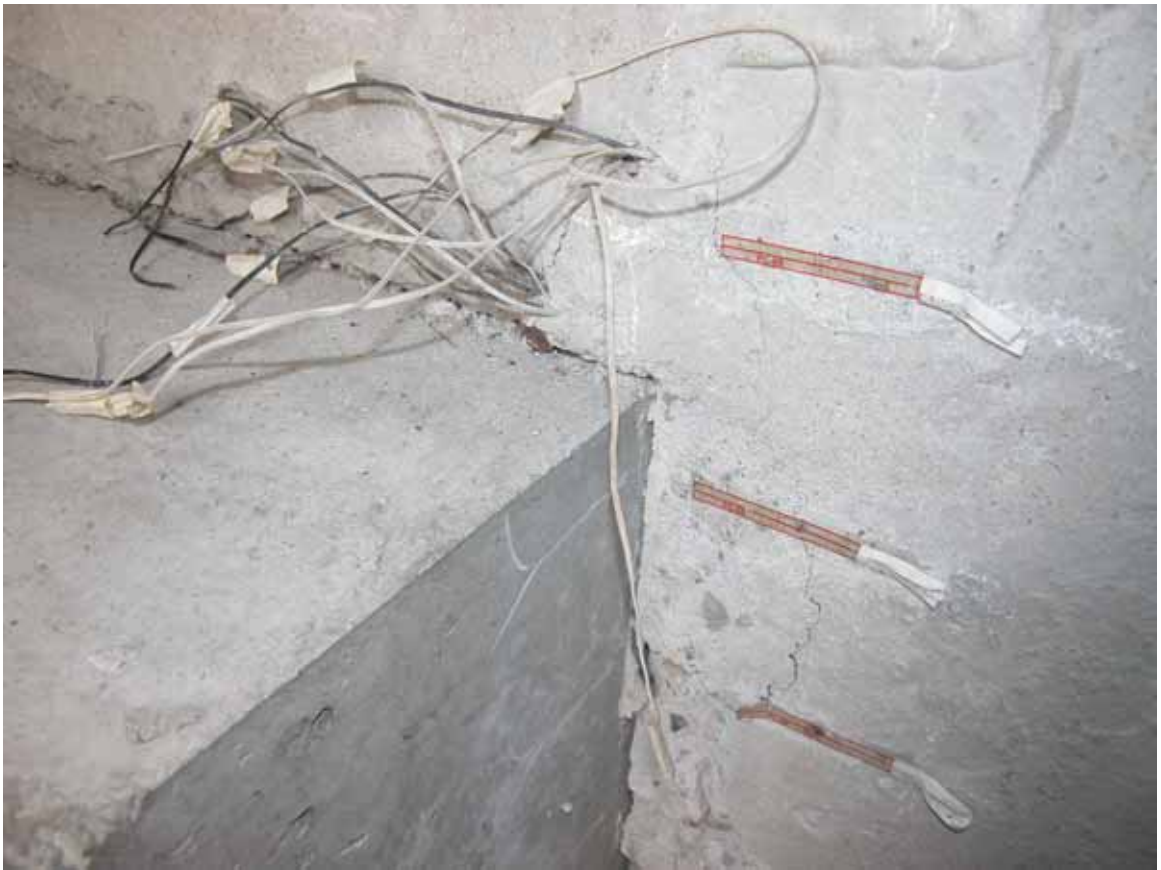
Рис. 3.19 – ФПП-2 (М3) на испытательном стенде после разрушения. Вид сверху
