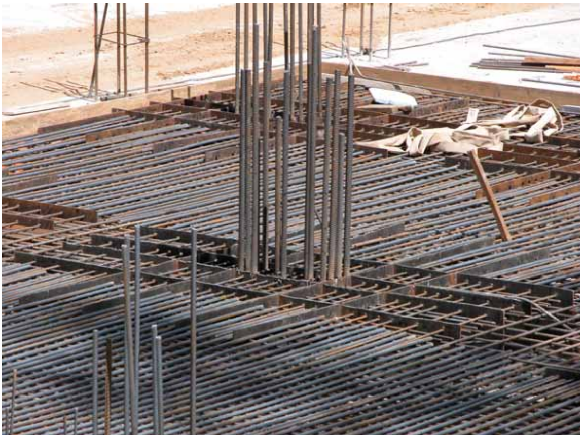
Рис. 1.6 – Фрагмент сплошной монолитной железобетонной фундаментной плиты
