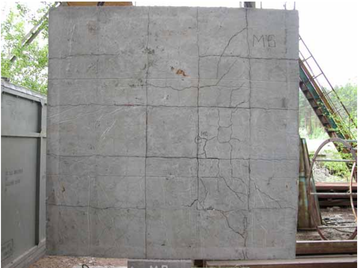
Рис. 3.26 – ФПП-5 (М6) после разрушения. Нижняя грань фрагмента плиты
