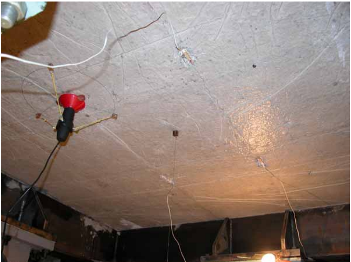
Рис. 3.22 – ФПП-3 (М4) на испытательном стенде перед разрушением. Вид снизу
