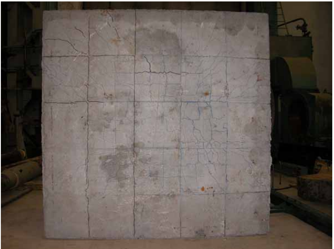
Рис. 3.28 – ФПП-6 (М7) после разрушения. Нижняя грань фрагмента плиты
