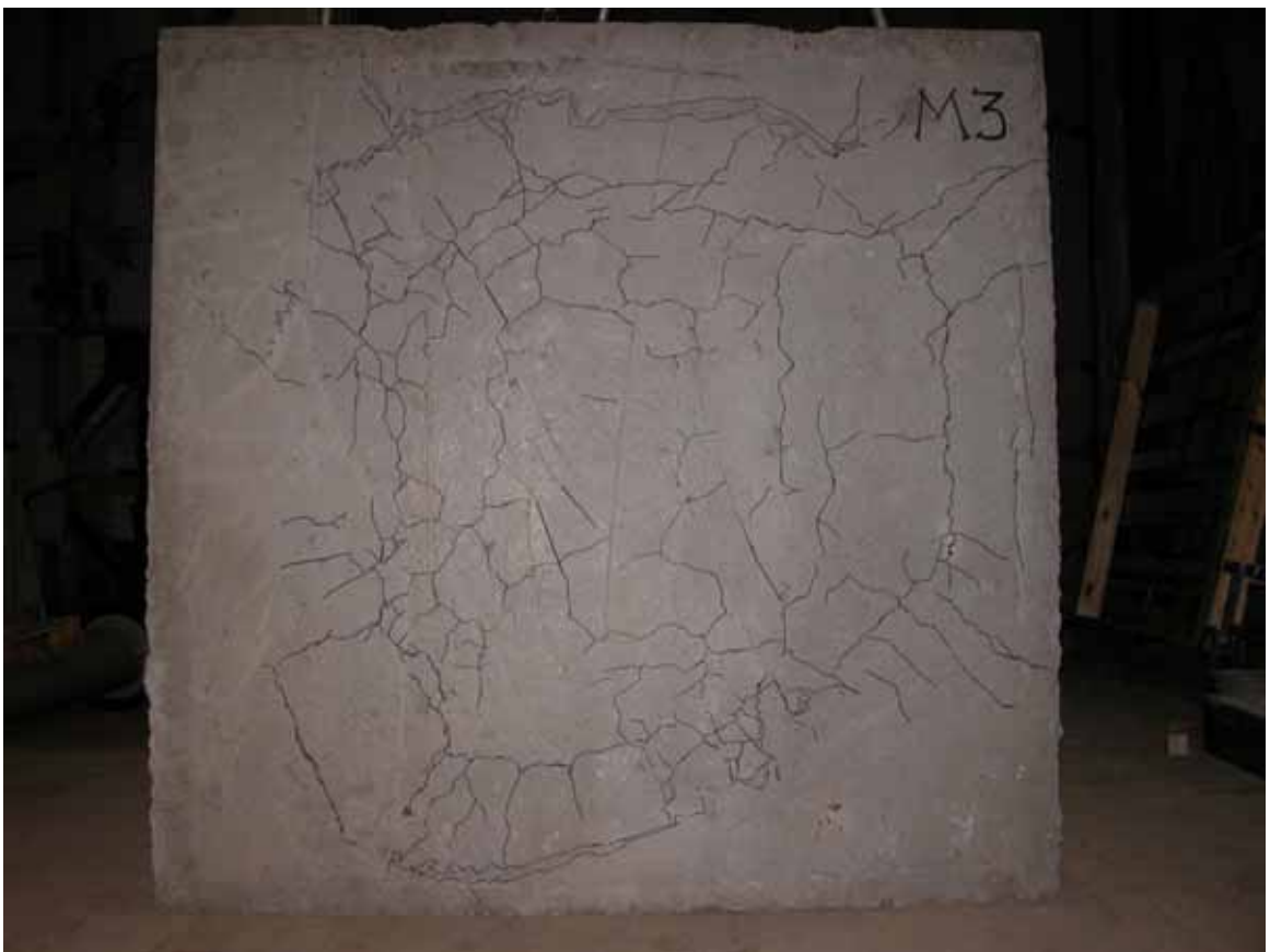
Рис. 3.20 – ФПП-2 (М3) после разрушения. Нижняя грань фрагмента плиты
