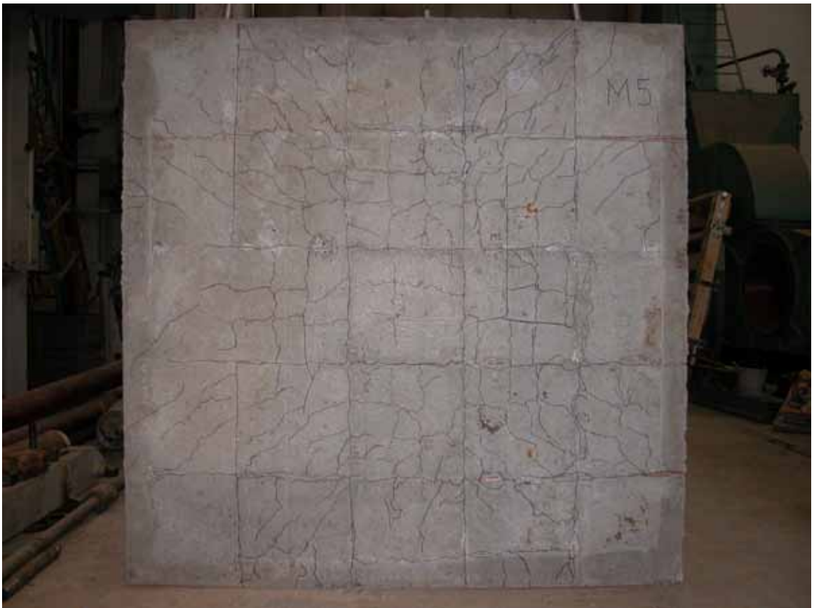
Рис. 3.24 – ФПП-4 (М5) после разрушения. Нижняя грань фрагмента плиты
