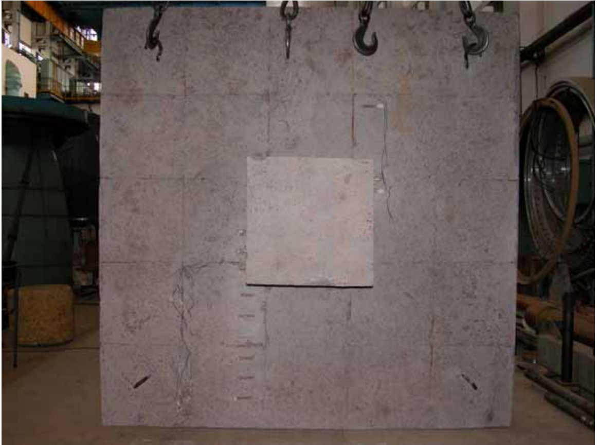
Рис. 3.23 – ФПП-4 (М5) после разрушения. Верхняя грань фрагмента плиты
