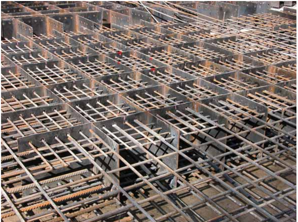
Рис. 1.5 – Фрагмент сплошной монолитной железобетонной фундаментной плиты
